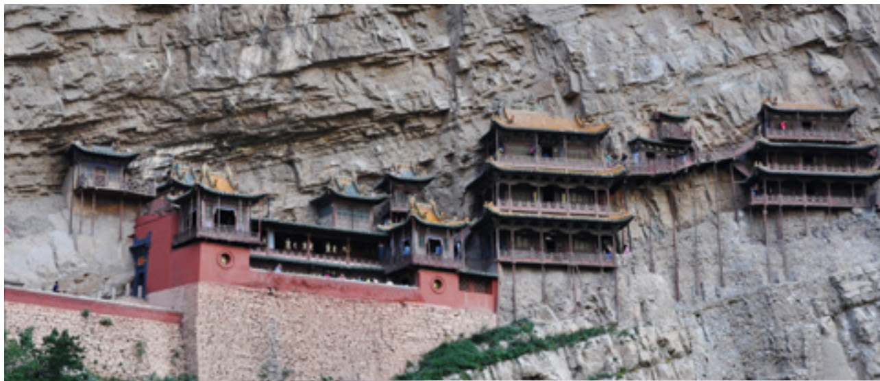
KESKENY LÉPCSŐSOROK VEZETNEK A FÜGGŐKOLOSTOR ÉPÜLETEIHEZ
